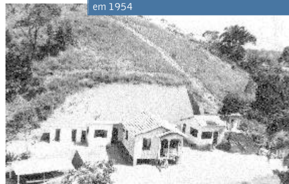
Fotos do início das obras da Base, em 1954
